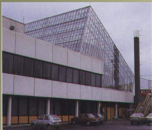
Büroanbau nach dem Prinzip der „Grünen Solararchitektur“, Firma Tegut (1985) (Außenansicht)
