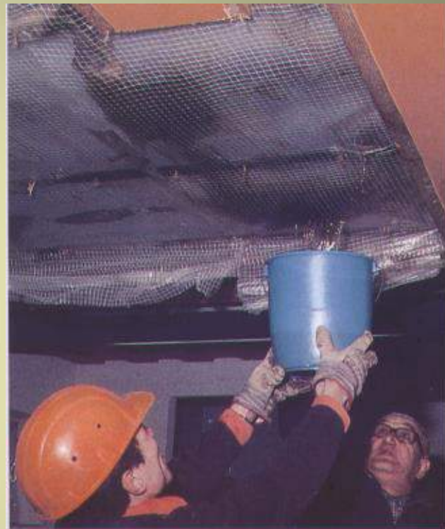
图片10: 清除水；在椽间的每块区域最多收集了40升水，才能保证在干燥环境下继续工作。
