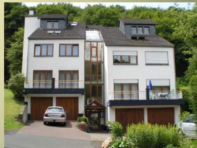
拥有9个居住单元的住宅楼
