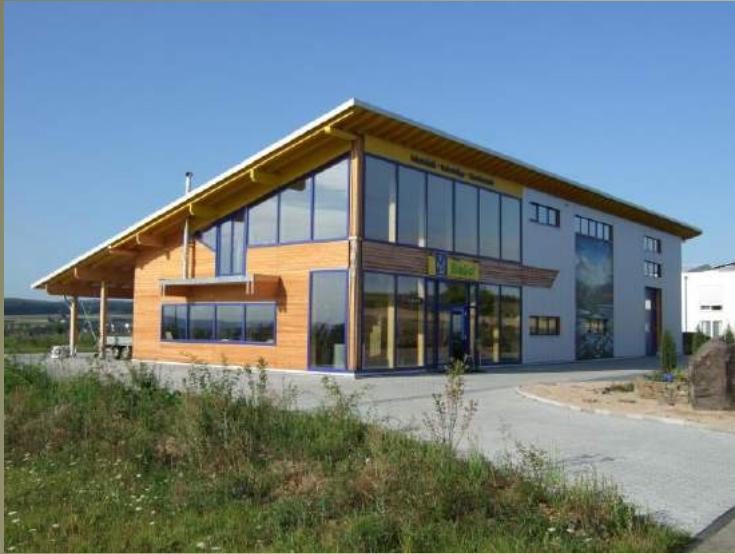
Biosol公司能源自己自足的厂房，2012年
